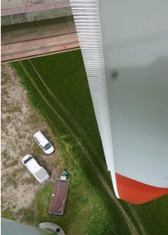
Abbildung 2: Installierte Serrations an einer Enercon E-82 (9)
