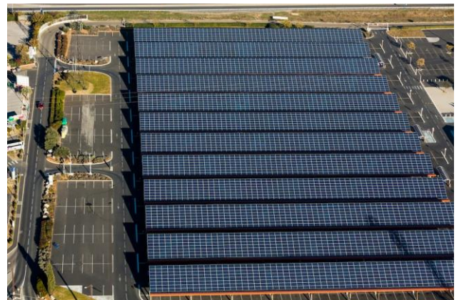
Abbildung 1: Großraum-Parkplatz mit PV-Überdachung (6)
