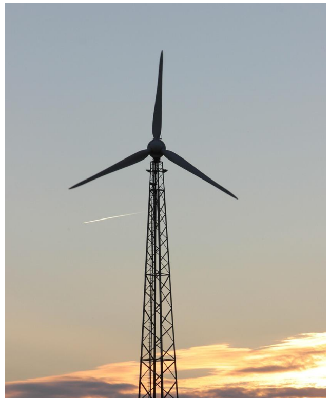
Abbildung 2: Beispielbild einer WEA mit Stahlgerüstturm. Foto: Uwe Jelting
